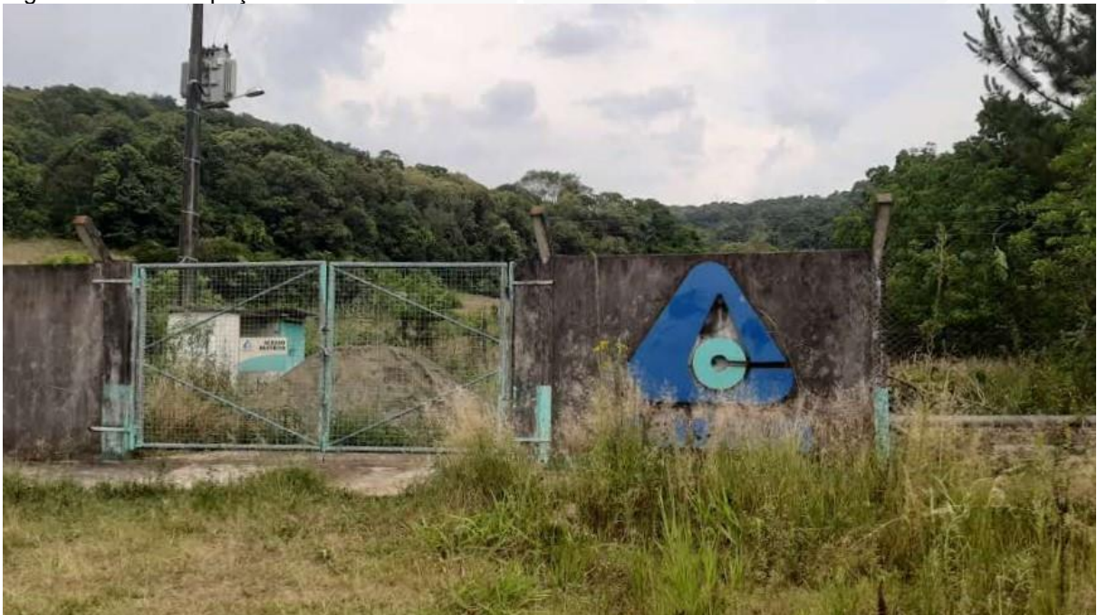
Figura 26: Área do poço 01.
