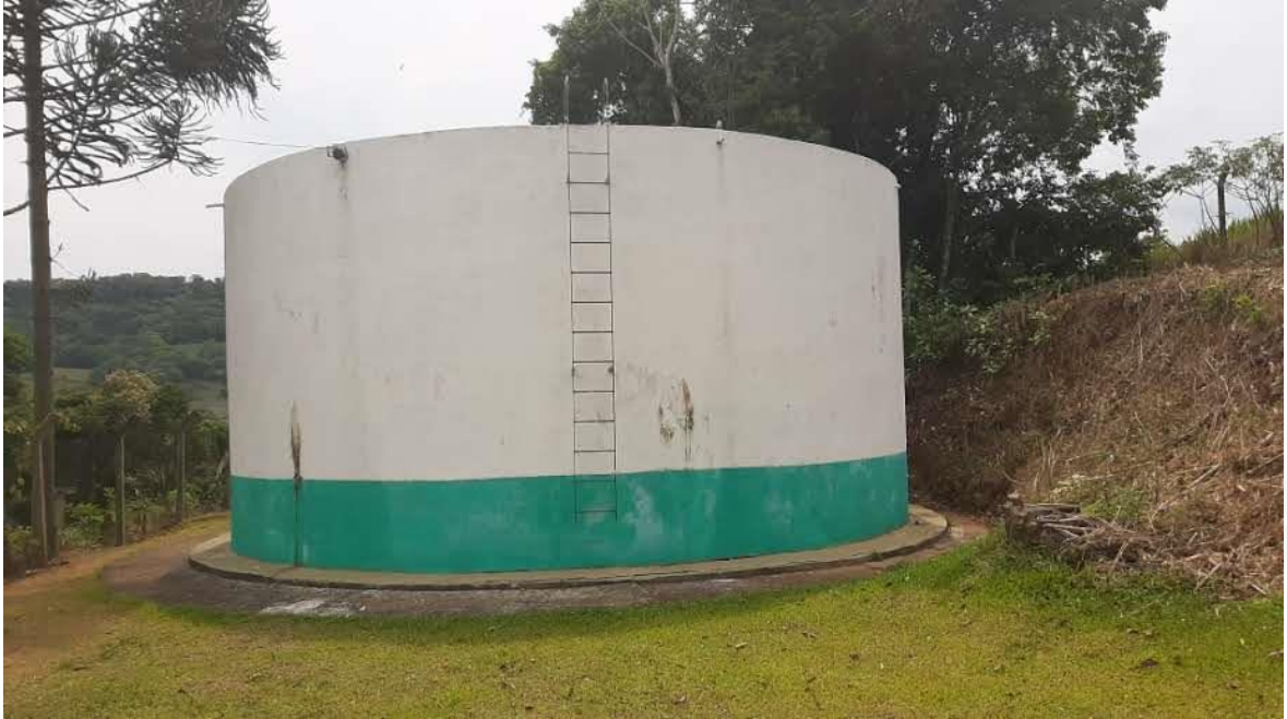
Figura 39: Centro de reservação R1 – 250m 3 .
