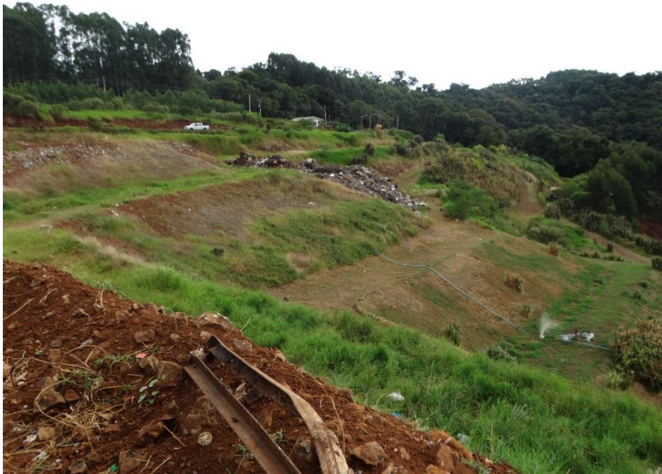
Figura 87: Cobertura das células encerradas com gramíneas e vegetação nativa e exótica formando a cortina vegetal.
