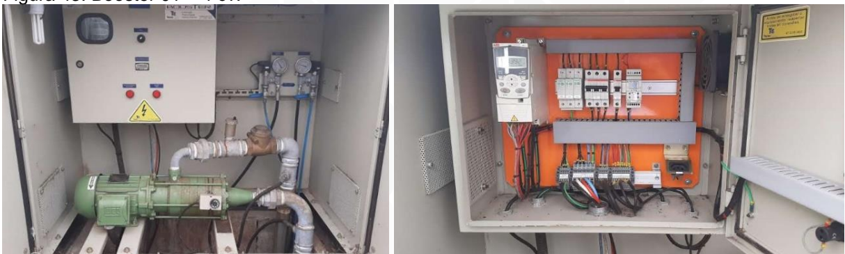
Figura 43: Booster 01 – 4 cv.
