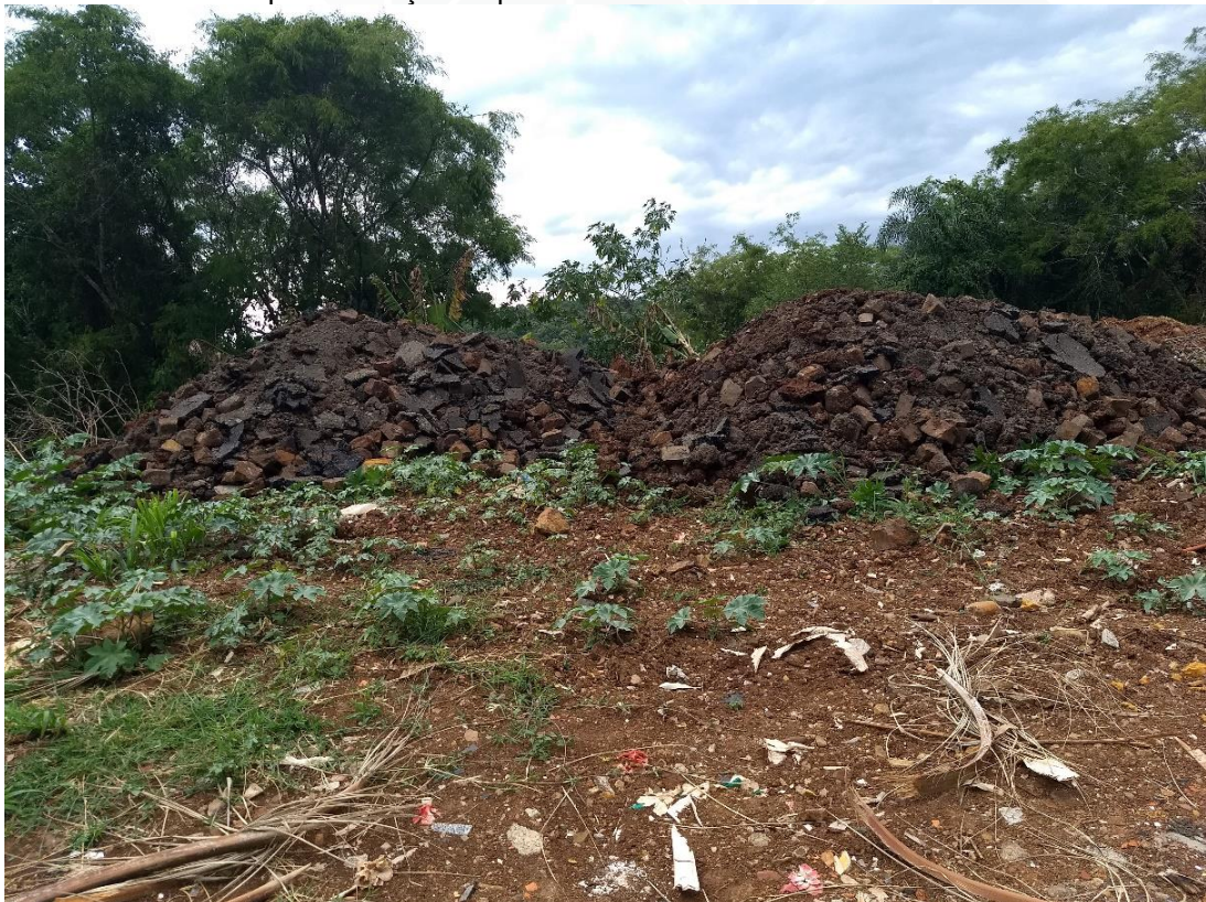
Figura 104: Resíduos de pavimentação disposto no local.
