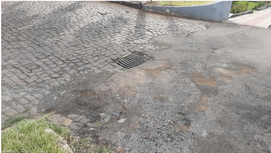
Figura 130: Boca de lobo localizada na entrada do Hospital.
