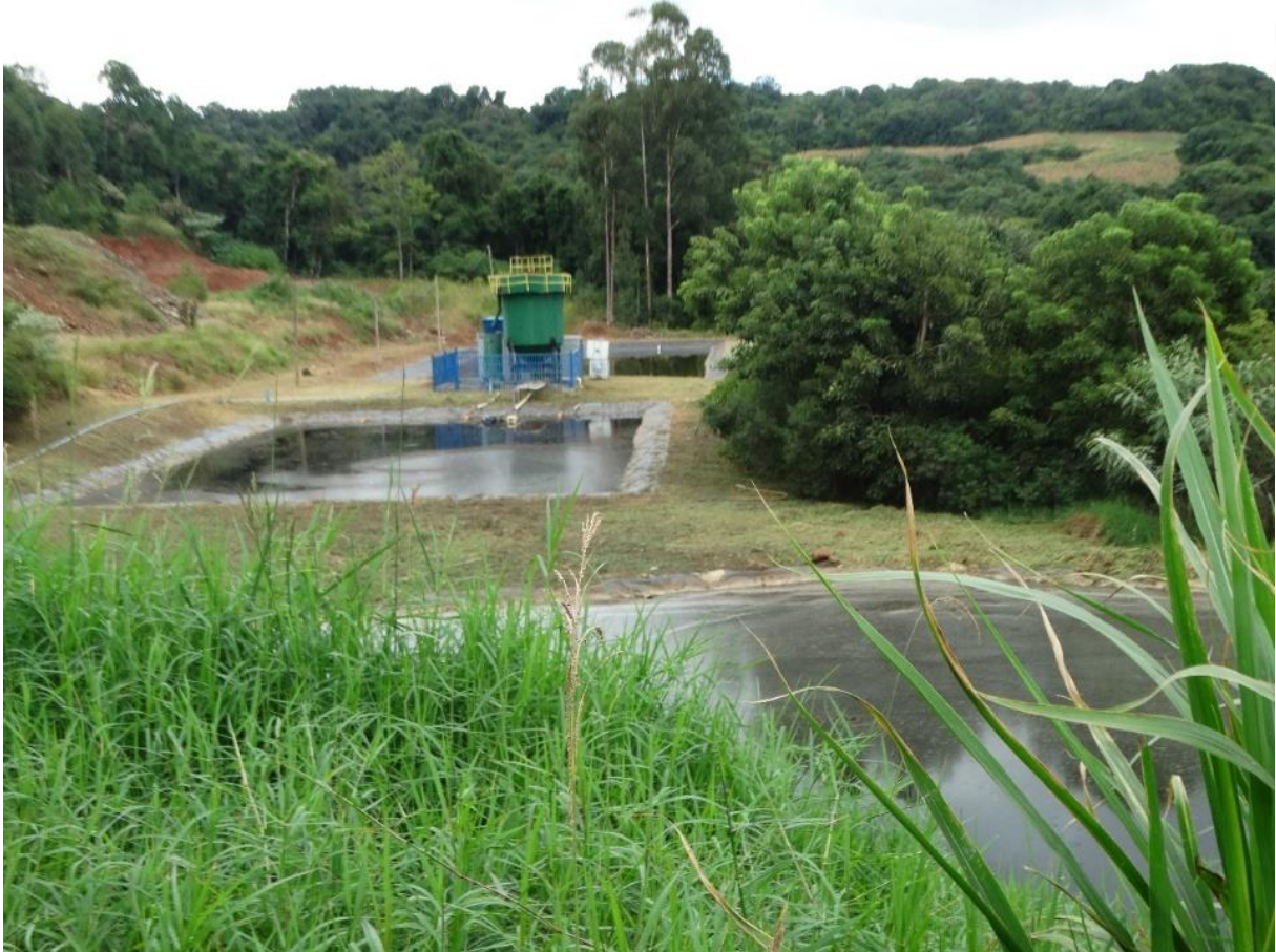
Figura 95: Visão geral do sistema de tratamento do líquido percolado.
