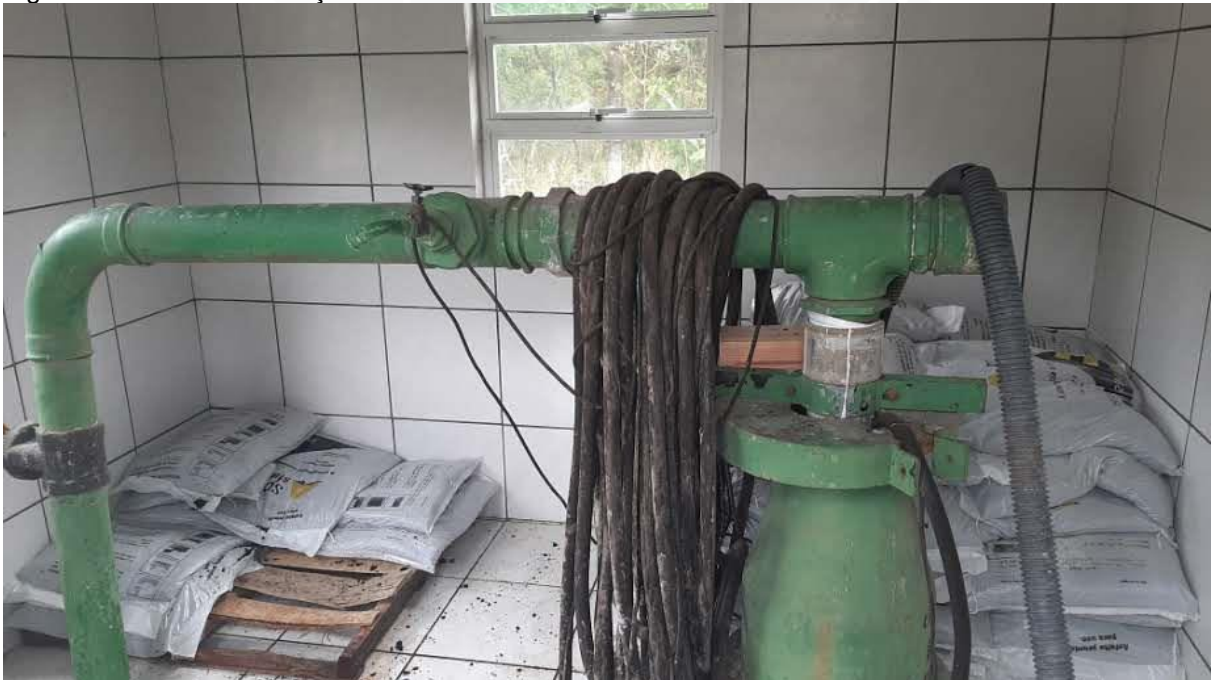
Figura 28: Cavalete do Poço 01 – Armazenamento de materiais ao fundo.
