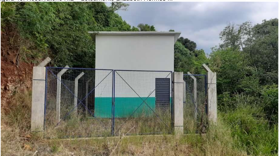
Figura 40: Reservatório R.2 – Loteamento Elizabeth Hermes II.
