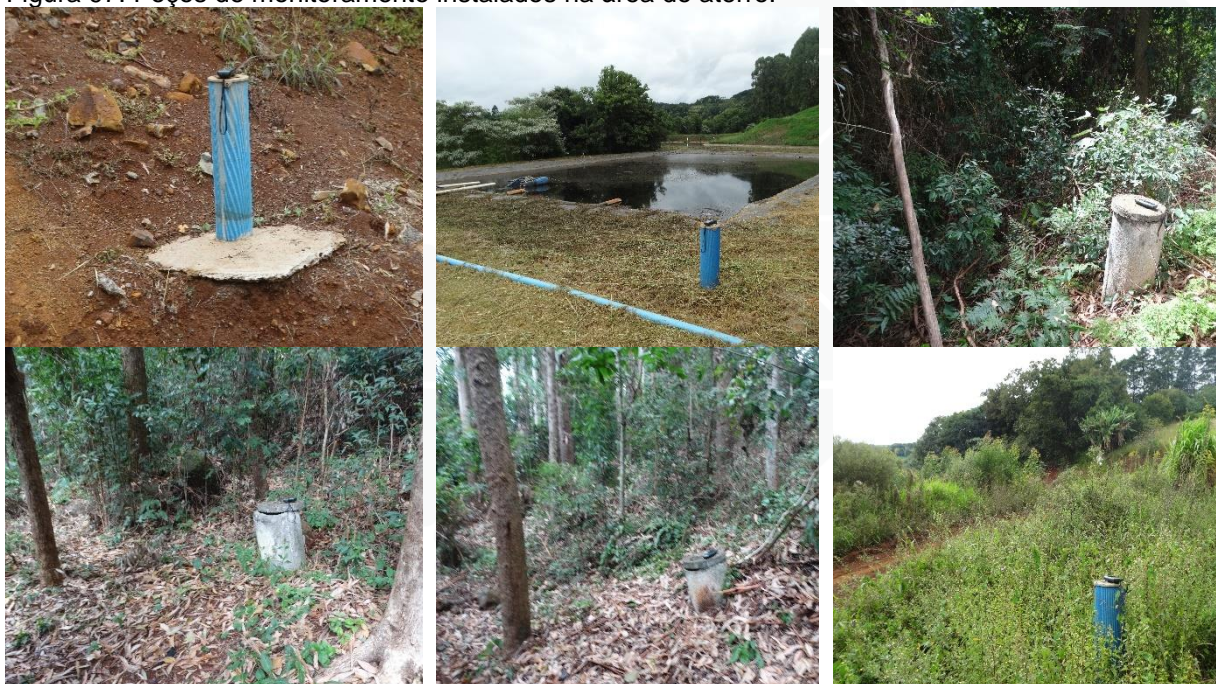
Figura 97: Poços de monitoramento instalados na área do aterro.
