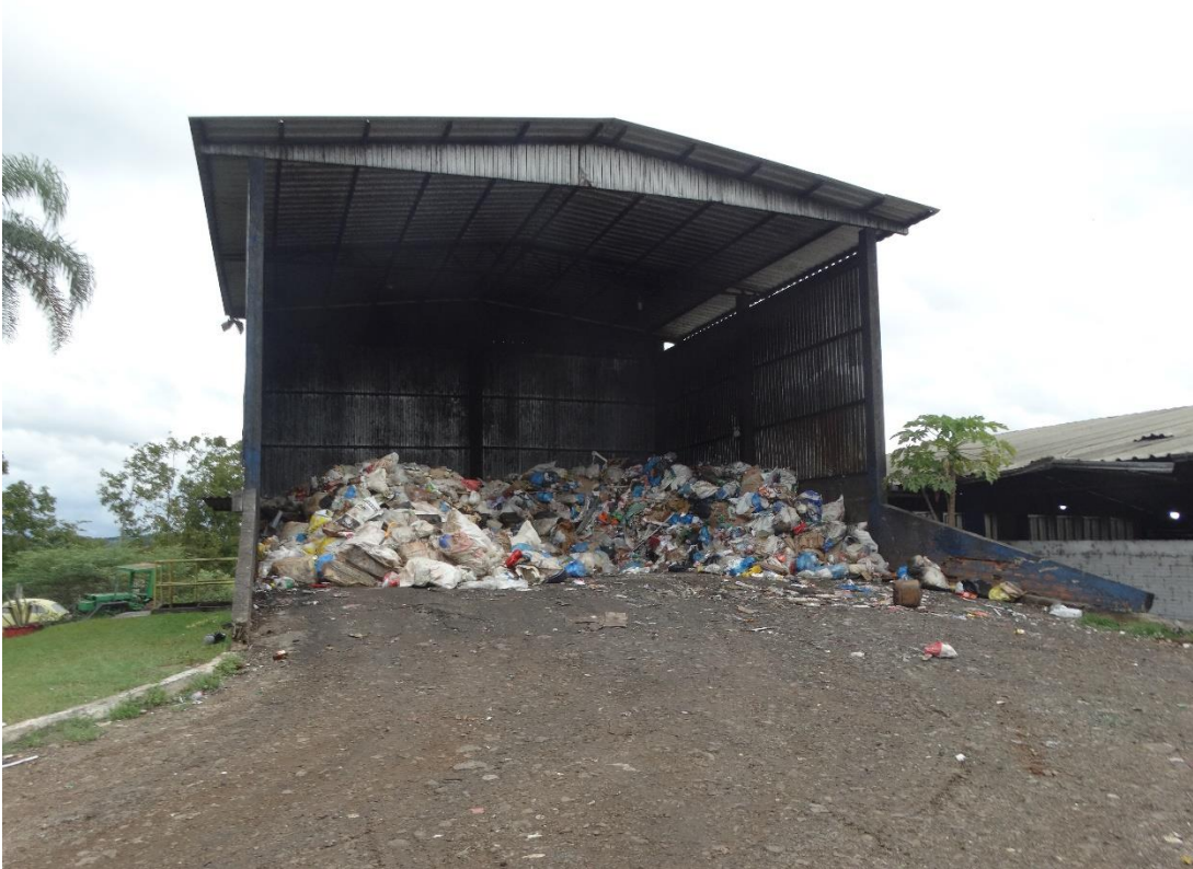
Figura 75: Barracão de recepção de resíduos.
