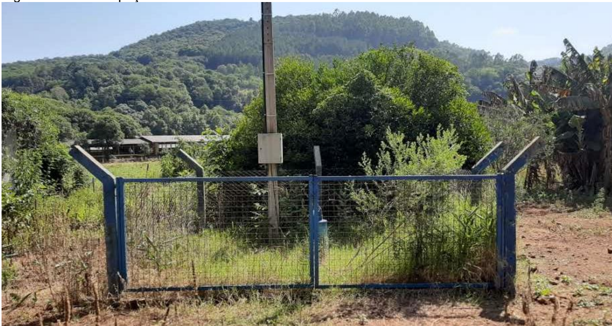
Figura 51: Área do poço.
