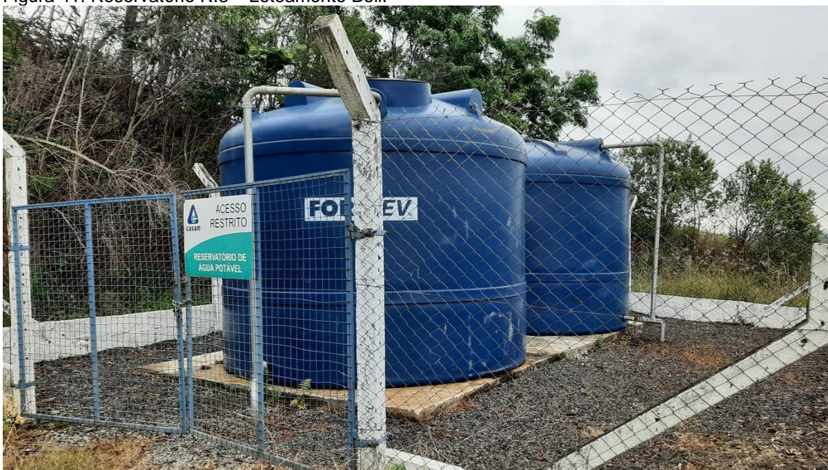
Figura 41: Reservatório R.3 – Loteamento Boll.
