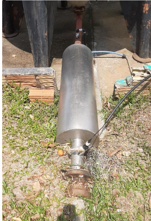
Figura 31: Turbo reator – dosagem de PAC e mistura rápida.
