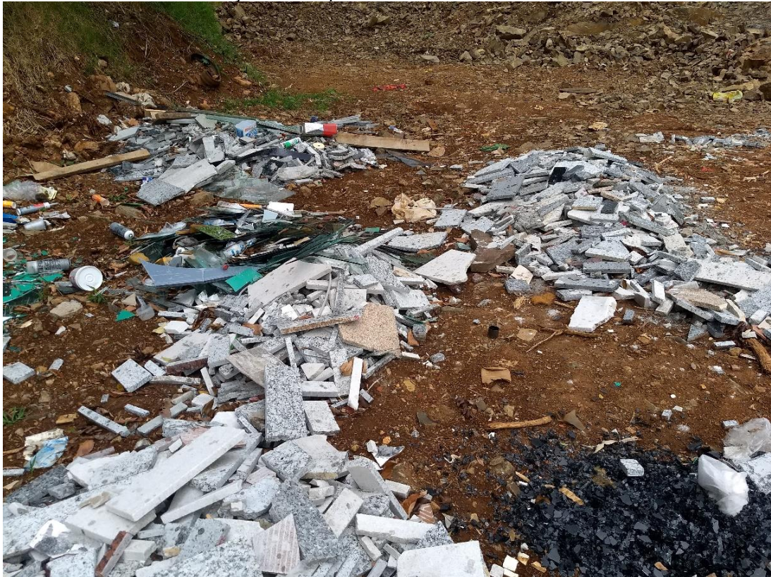
Figura 105: Resíduos de construção civil dispostos no local.
