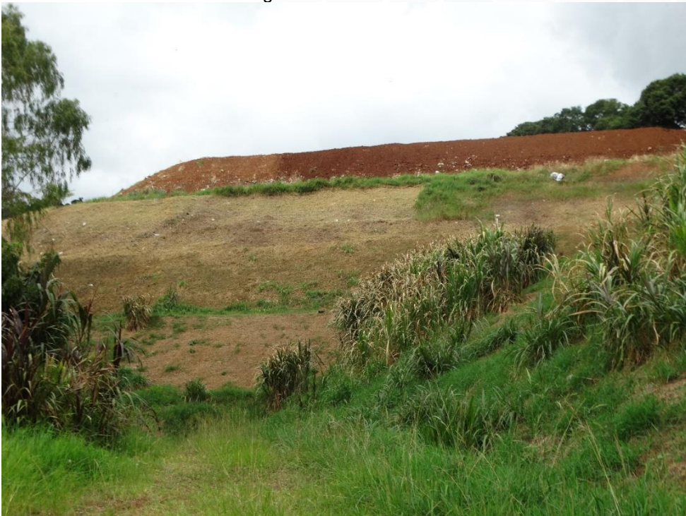
Figura 90: Ausência de sistema de drenagem.
