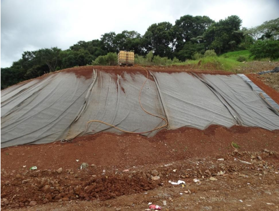
Figura 89: Impermeabilização da célula encerrada com PEBD.
