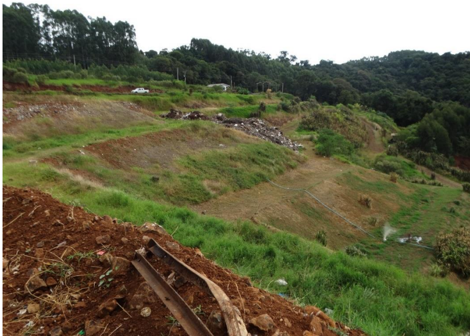
Figura 96: Sistema de recirculação de efluentes no aterro.
