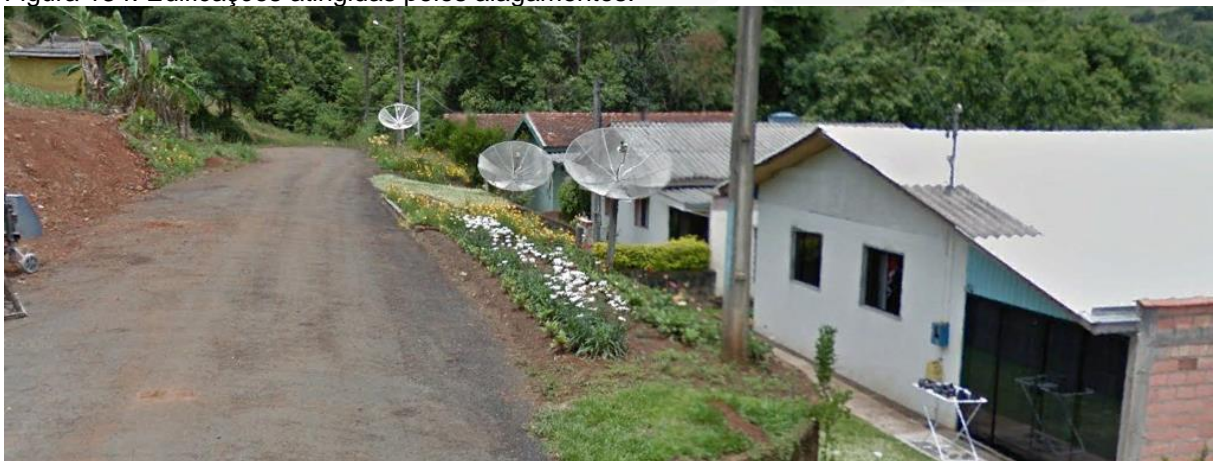
Figura 134: Edificações atingidas pelos alagamentos.
