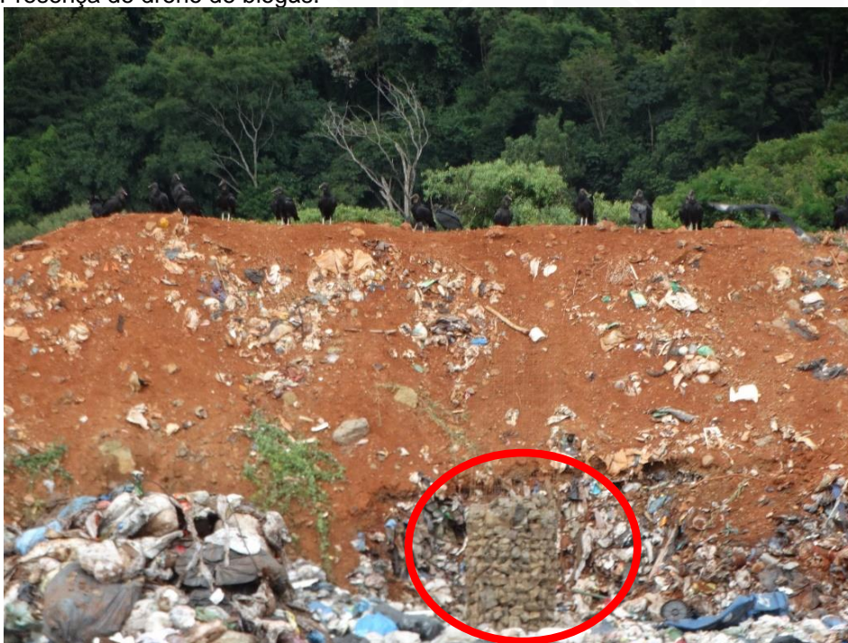
Figura 94: Presença de dreno de biogás.
