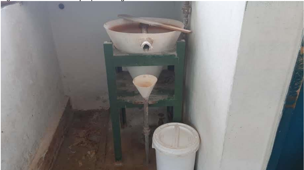
Figura 35: Cone de saturação para dosagem de fluossilicato de sódio.
